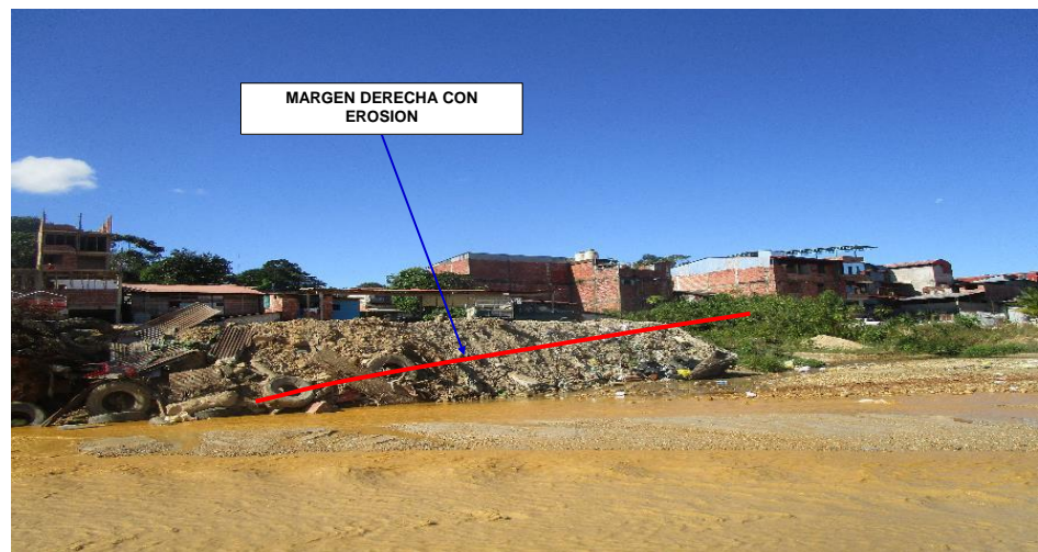
FIGURA N° 02: RÍO HUAYPETUE (RIO HUEPETUHE), PROTEGIDO CON MATERIAL IMPROVISADO ZONA BAJA DE HUEPETUHE
